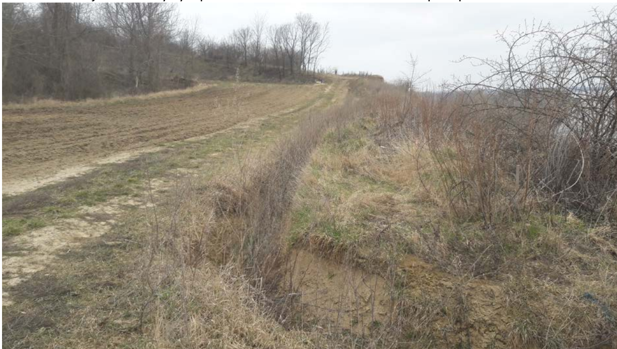
Obr. č.1 - stávající zanesený výkop v místě navrženého nadzářezového příkopu
