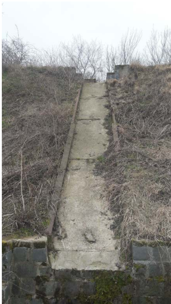
Obr. č.3 - stávající kamenobetonový skluz se zaústěním do vývařiště nad propustkem č.2
